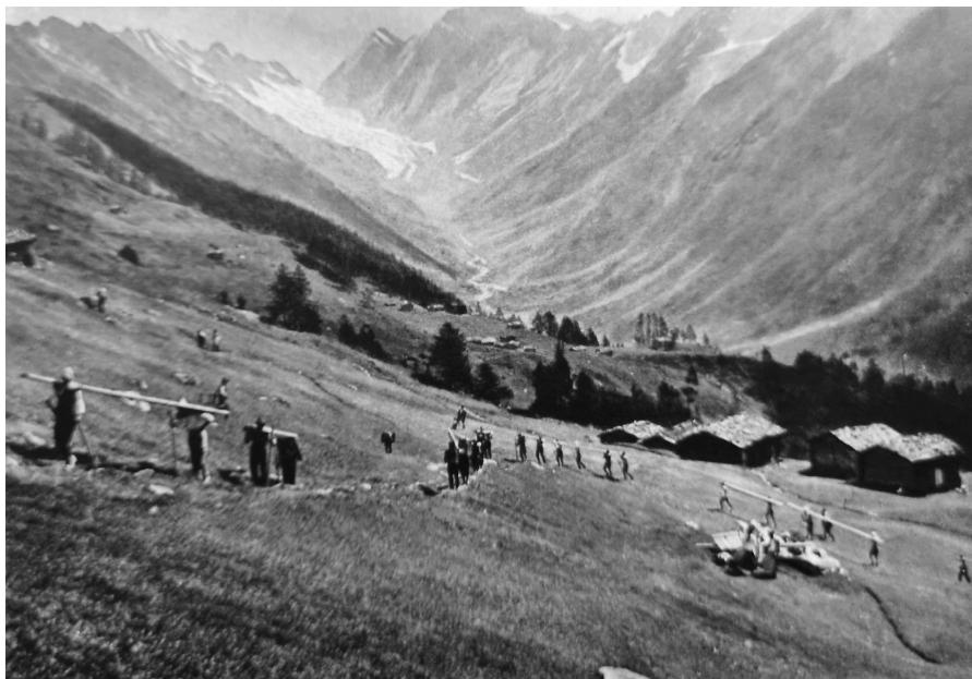
Transport communautaire de poutres de mélèze pour la construction du Block-bau, Loetschental, v. 1920. © W. Derichsweiler, 1920; source: Luigi Zanzi, Enrico Rizzi, Le Alpi, architettura e civilizzazione, Fondazione Enrico Monti, Domodossola, 2016, p. 93.
